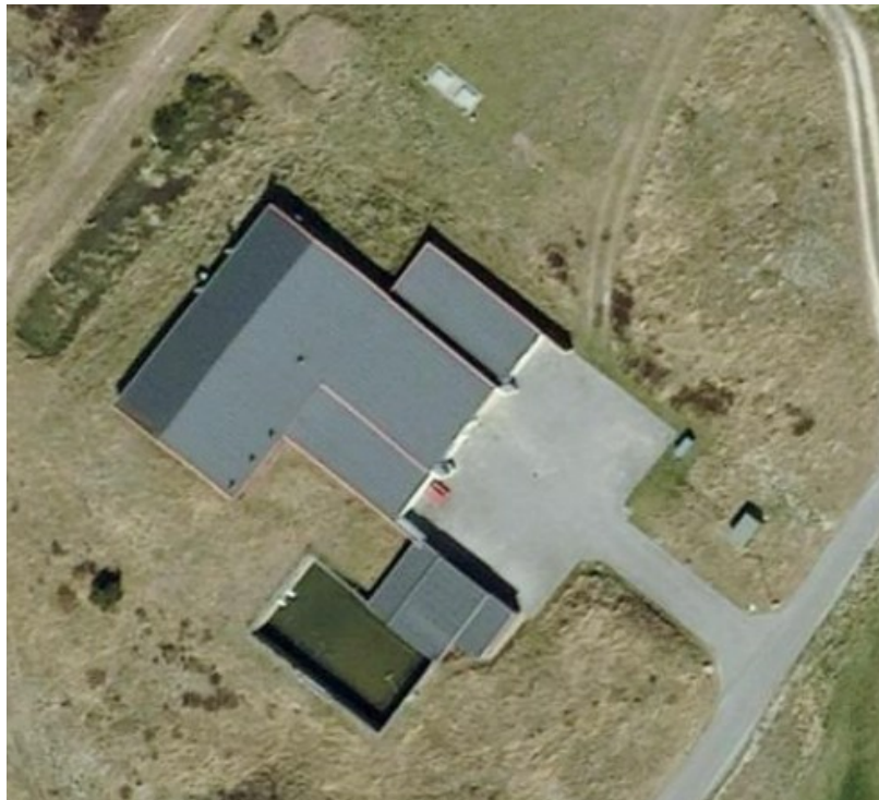
Figur B-1-0-1 viser Fanø Vandværk ovenfra 2022
