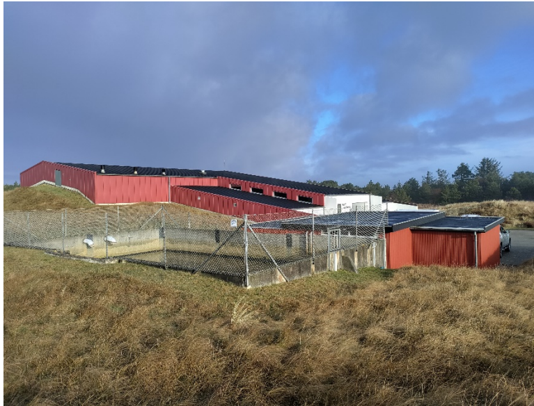
Figur 5-1 viser Fanø Vandværk med slambed i forgrunden.
